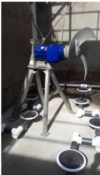
Nach dem Neubau des Sandfanges wurden weitere umfassende Investitionen und Modernisierungen in die Kläranlage in Abschnitten durchgeführt. Derzeit erfolgte die Erneuerung des Rührwerkes bzw. des ersten Beckens (von insgesamt drei).
