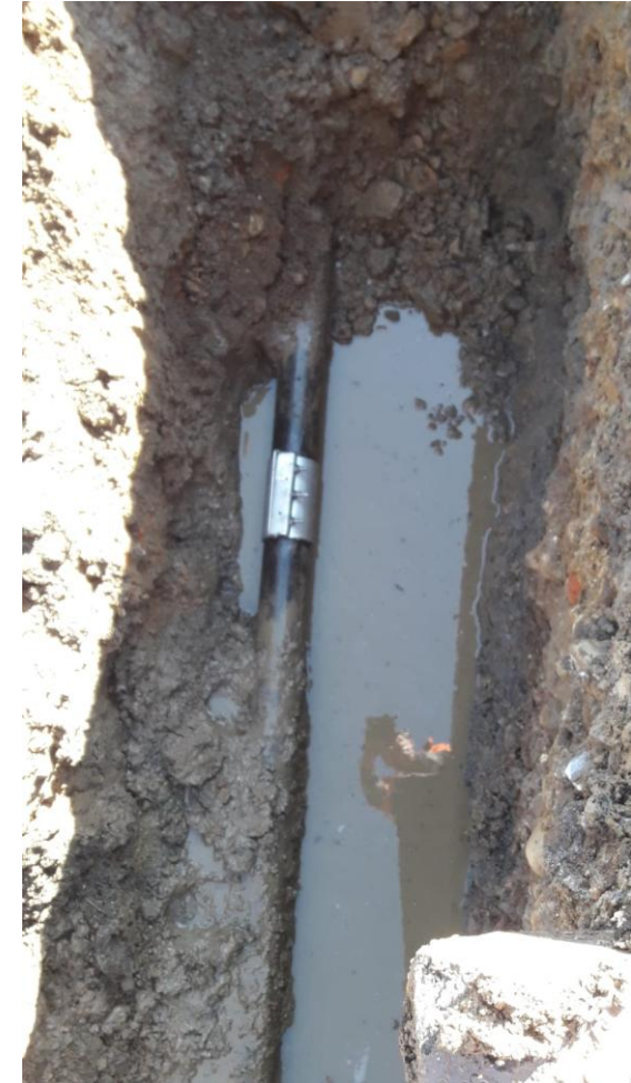
repariertes Rohr
