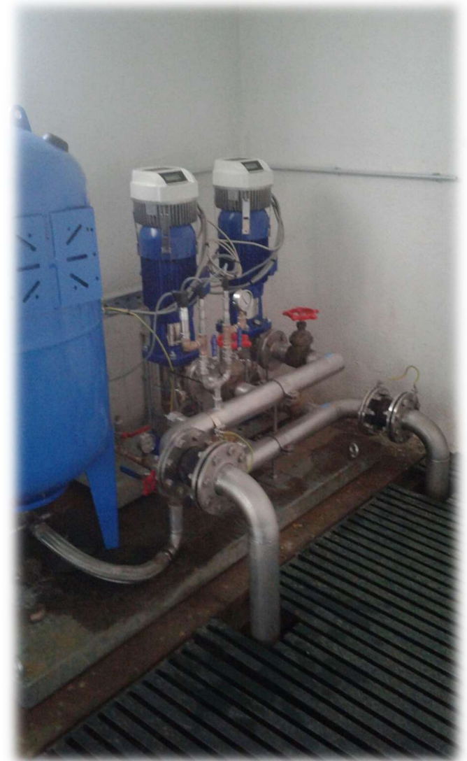
Erneuerung Drucksteigerungsanlage
